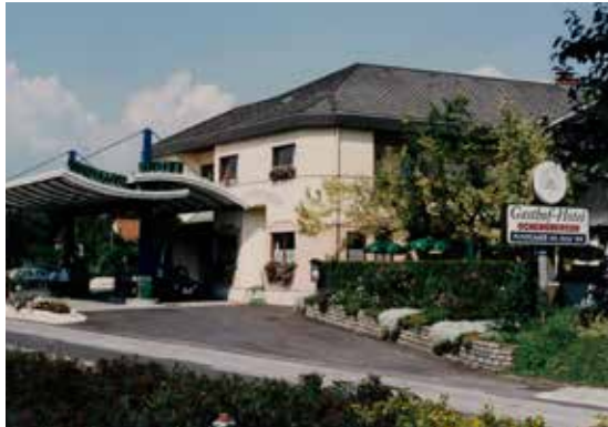
1997: Umbau der Tankstelle
